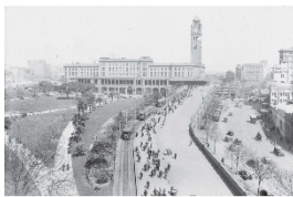
Belmore Park, 1923 บนถนนสายที่ตัดผ่าน Central Station
